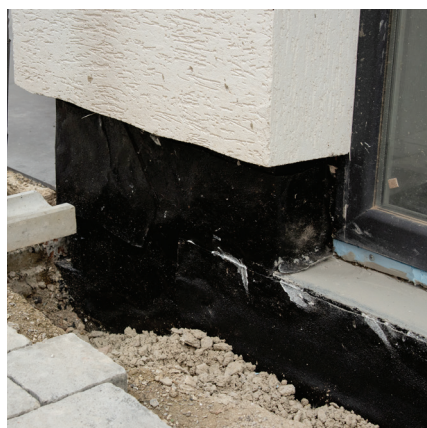
Impermeabilización exterior con Brea
