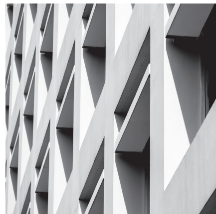
Impermeabilización fachadas hormigón
