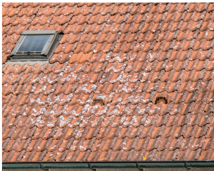
Humedad por filtración/tejado
