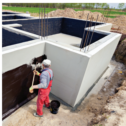
Impermeabilización muro enterrado con Brea
