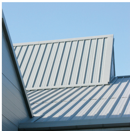
Impermeabilización-aislante cubierta metálica
