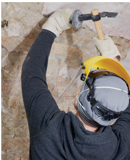
Picar, eliminar capas de revestimiento
