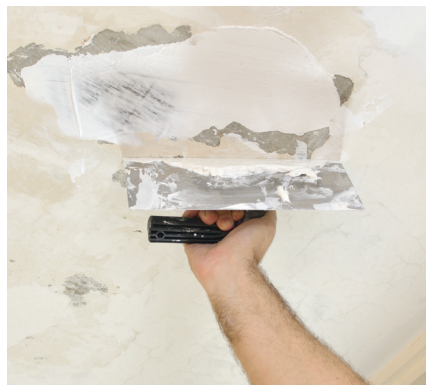
Relleno de grietas
